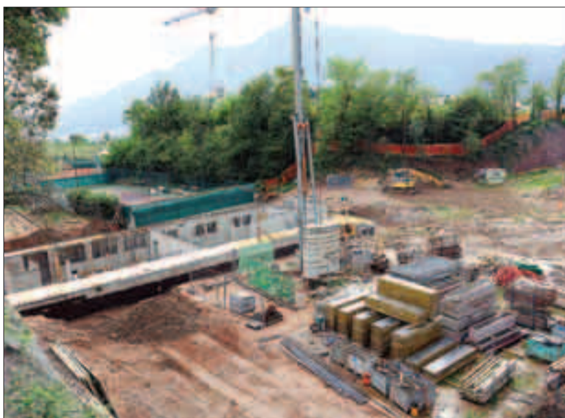
I lavori per la realizzazione della nuova palazzina
